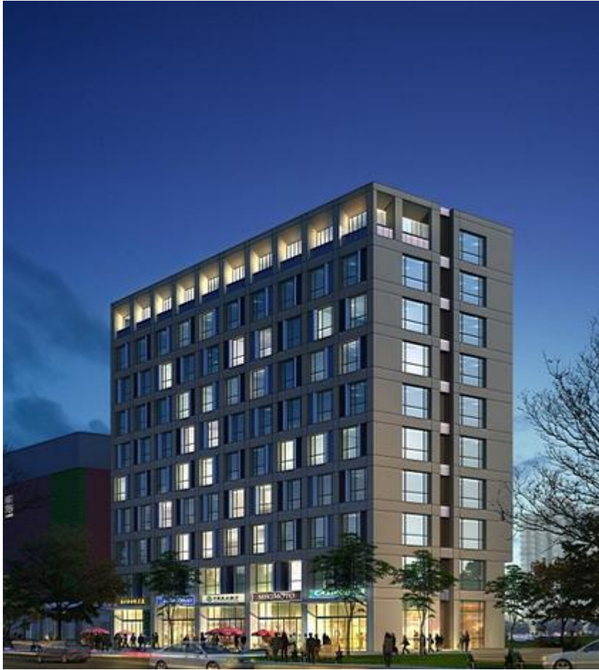
河北省某办公大楼建设项目
