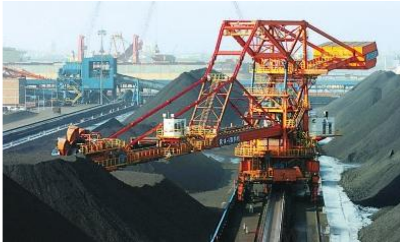
内蒙古某煤炭深加工工厂建设项目
