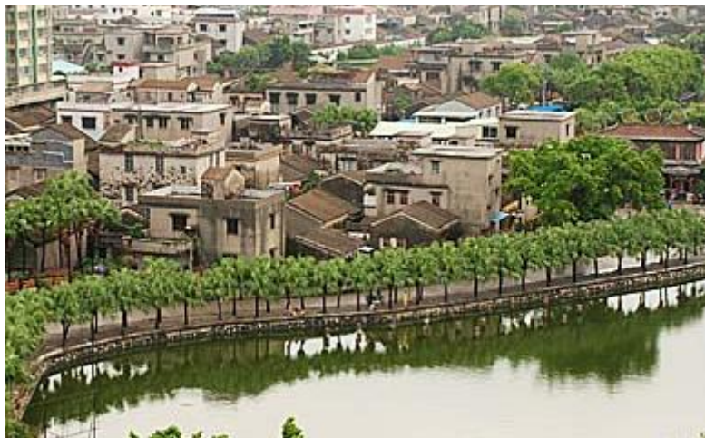
广东省某旧村庄改造项目
