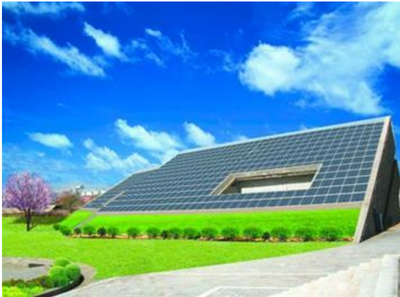
新疆某太阳能光伏发电工程项目
