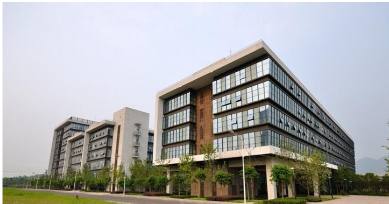
河北某成立股份制商业银行项目
