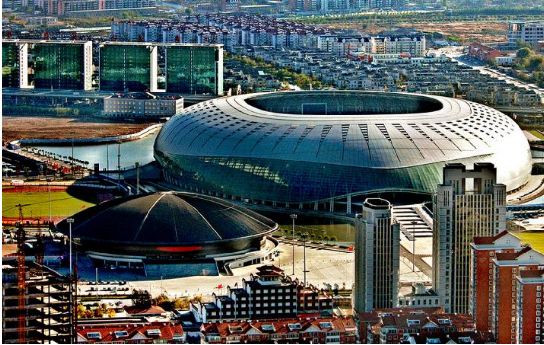
天津市体育健身馆建设项目
