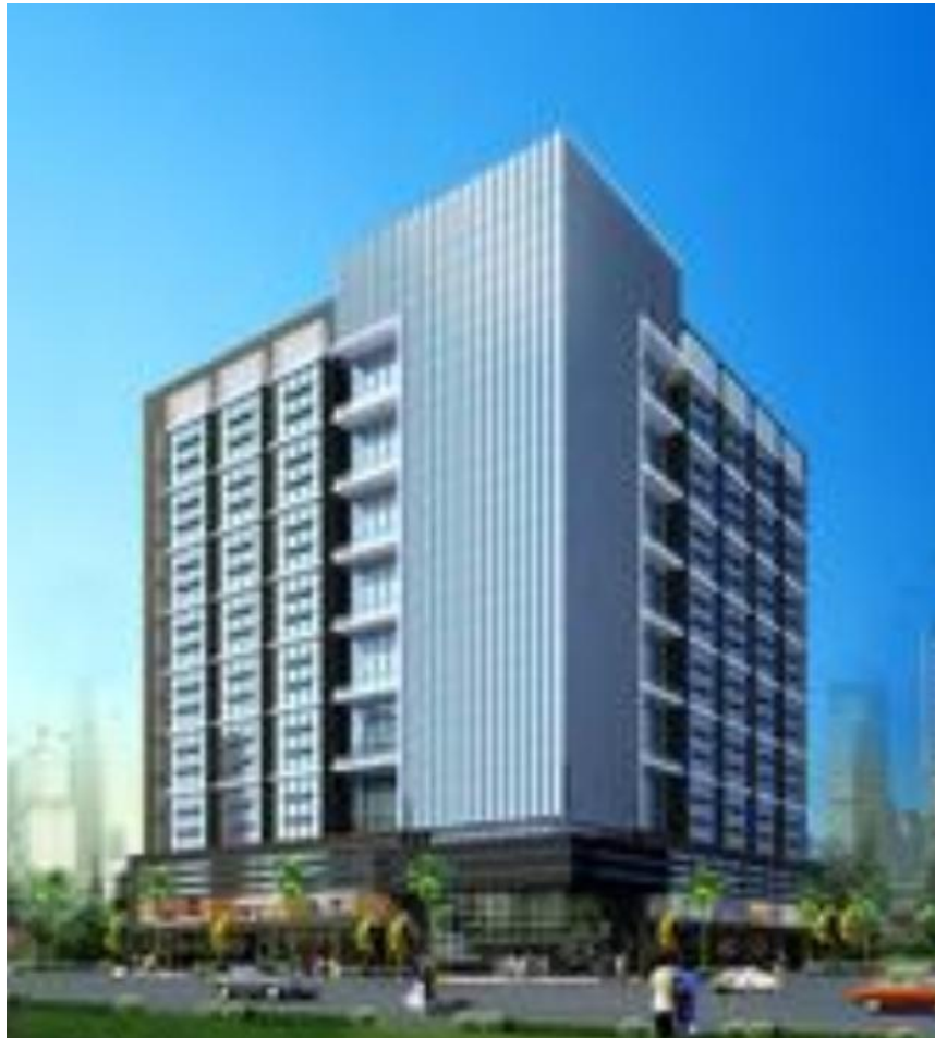
河南省某老年住宅公寓建设项目
