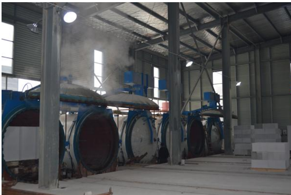
四川省某预拌混凝土市场整改项目
