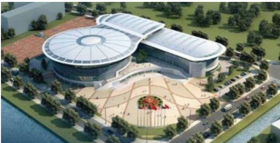
吉林省某体育馆建设项目
