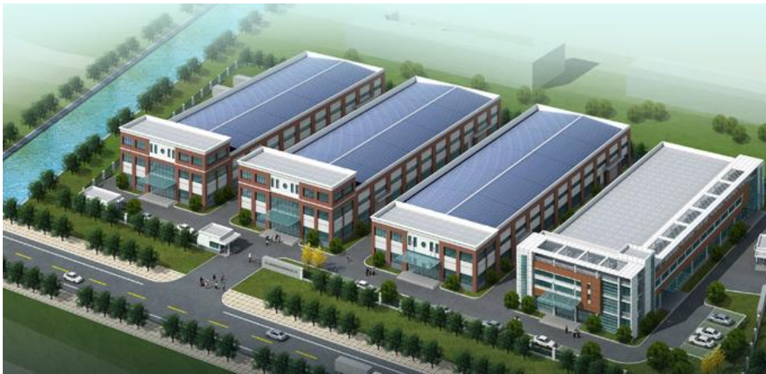
湖北省某公司冷链物流仓储建设项目
