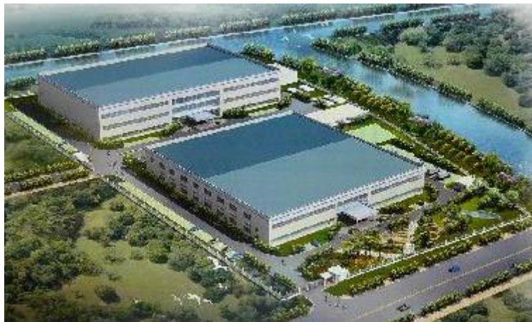
江苏省某公司变压器生产建设项目
