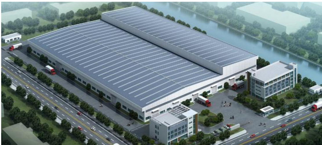
浙江某磷酸酯阻燃剂项目
