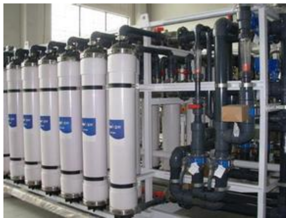
广西省某分离纯化装置产业化项目
