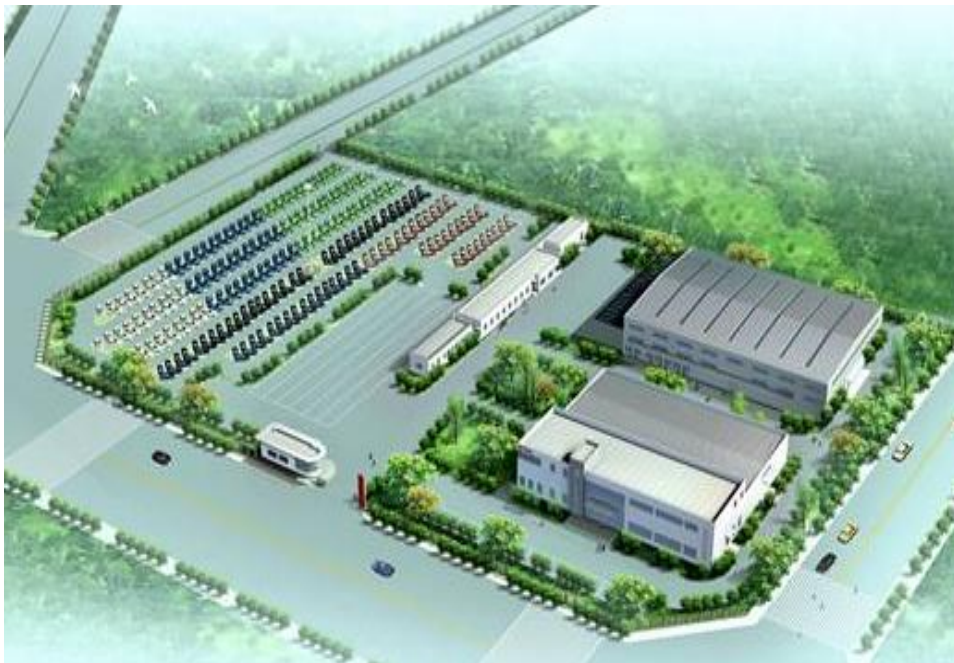
安徽省某汽车零部件物流基地项目
