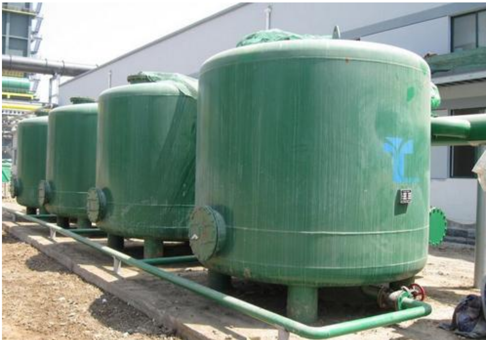
陕西某焦化技改项目
