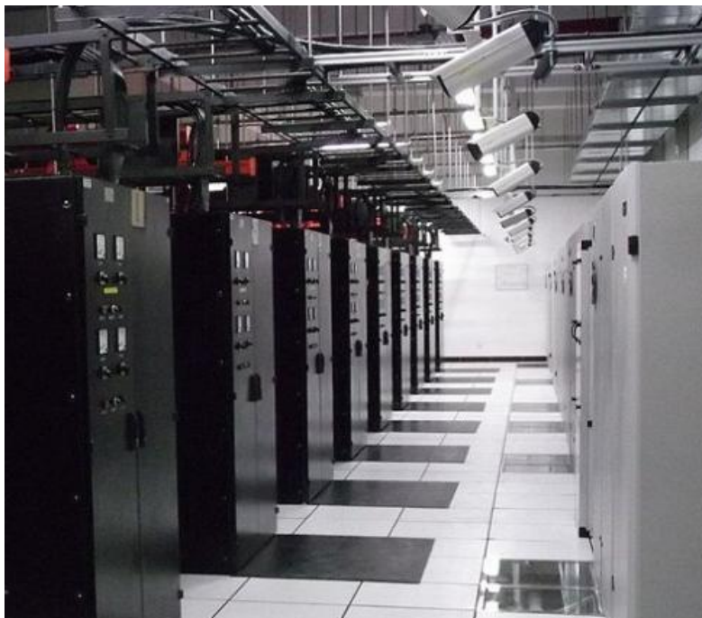
吉林省某电信技术服务中心项目
