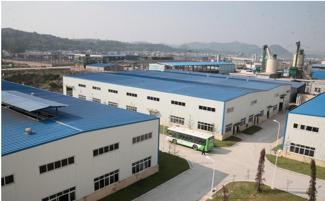
江苏省某公司高性能烟气脱氮（脱硝）催化剂产业化项目
