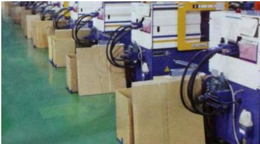
浙江省某伺服节能系统生产项目
