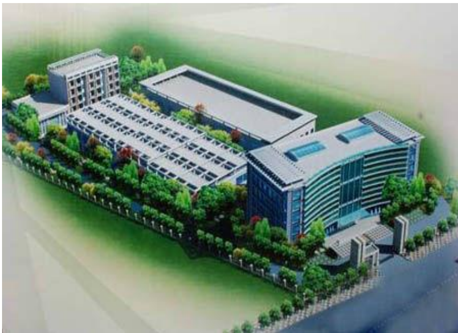
江苏省某数字视觉运营中心建设项目
