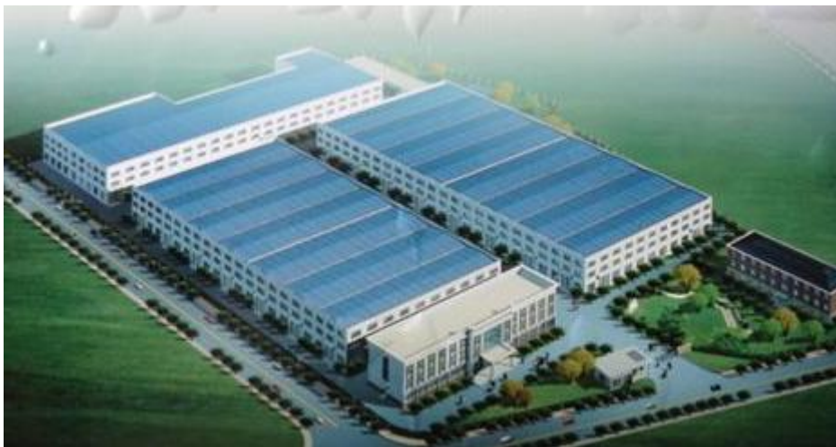
辽宁某离心压缩机项目
