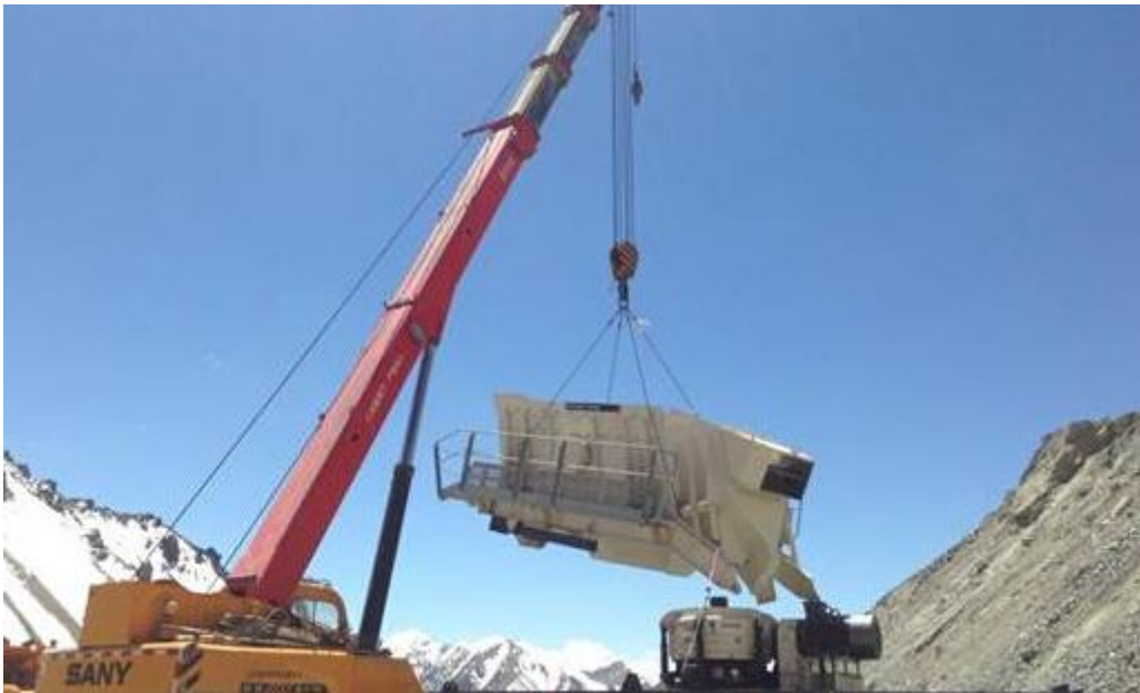
北京某矿山基建及采矿设备购置项目
