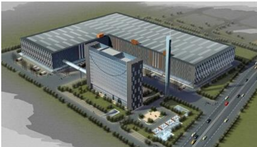
四川省某物流配送中心建设工程项目
