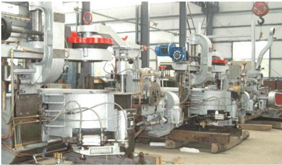
山东省某档玻璃器皿生产线技术改造项目
