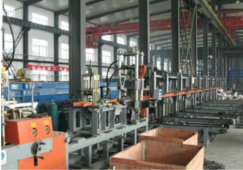
天津某预应力钢材生产线建设项目
