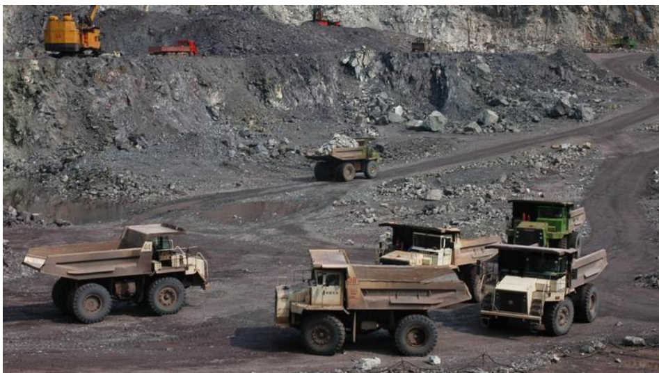
西藏某铅锌矿选厂工程项目
