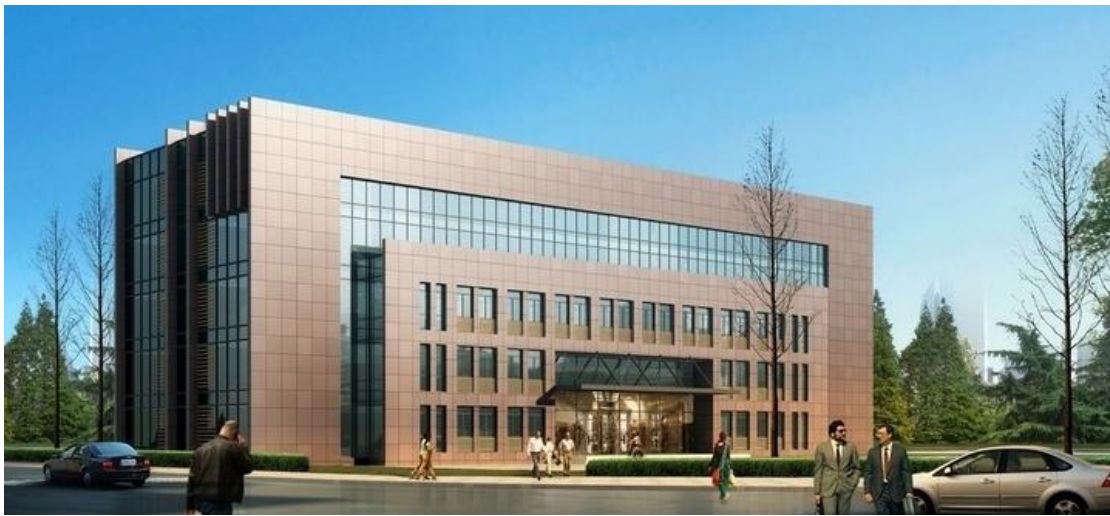
湖北省水电施工技术工程研究中心建设项目
