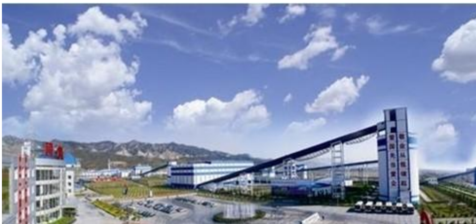
湖南省循环经济工程固体废物利用项目
