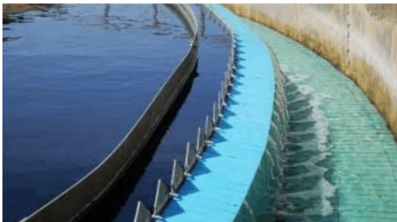
江苏某县农村饮用水安全工程项目
