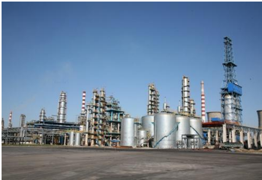
山东省年产 50 万吨延迟焦化工程项目
